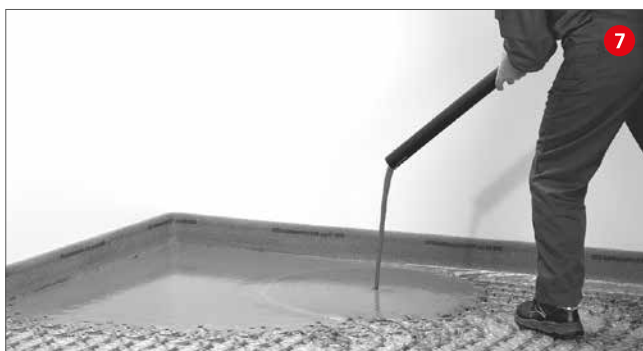
7. Auftragen der Füll- und Vergussmasse
